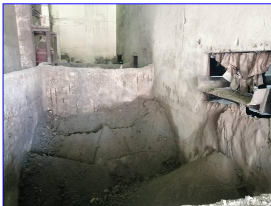
รูปที่ 2.23 บ่อคอนกรีตเก็บเถ้าลอย – เถ้าหนัก
