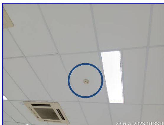
รูปที่ 2.11 ระบบตรวจจับควัน (Smoke Detector)
