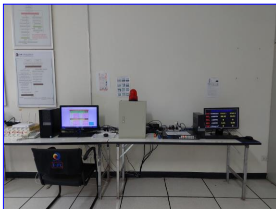
รูปที่ 2.38 หน้าจอแสดงผลค่า CEMs และ alarm เตือนเมื่อ CEMs มีค่าสูงผิดปกติ
