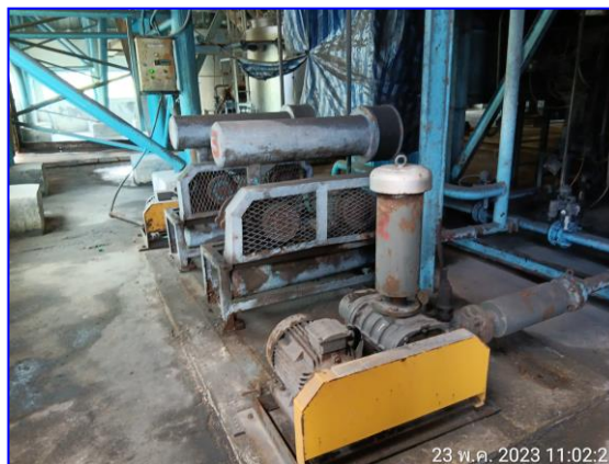
รูปที่ 2.19 ติดตั้งอุปกรณ์ดูดถ่านกัมมันต์ ( Activated Carbon ) เพื่อดูดซับ Dioxin
